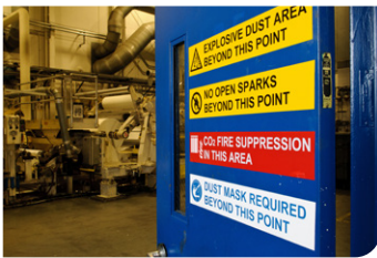
Panneaux de sécurité
